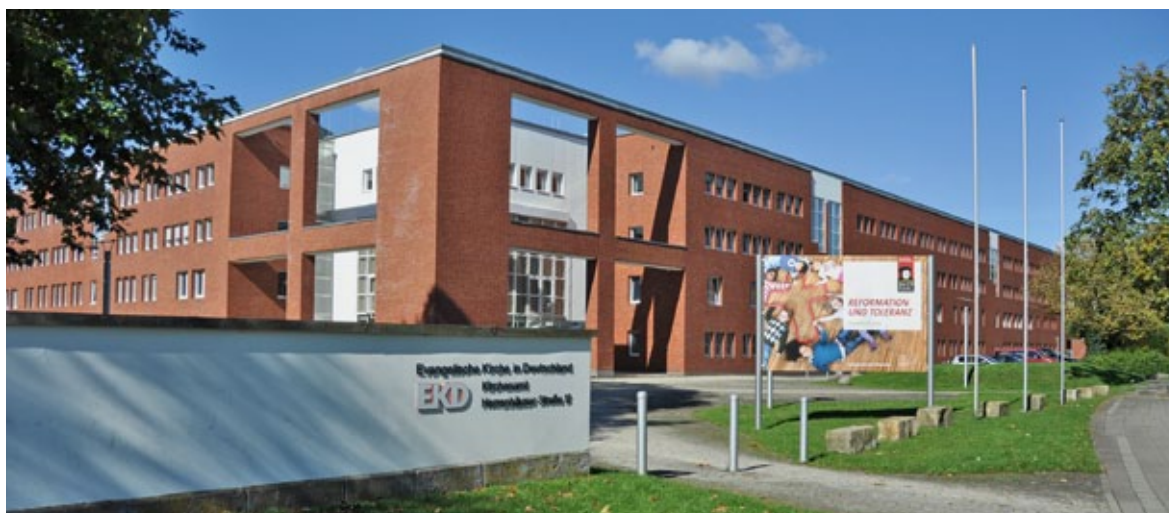
Kirchenamt der EKD in Hannover, Herrenhäuserstraße
